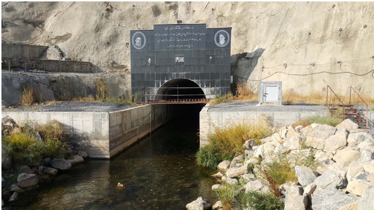
خروجی تونل انتقال به مخزن سد گلپایگان (دبی فعلی ۱۲۰۰ لیتر بر ثانیه)
